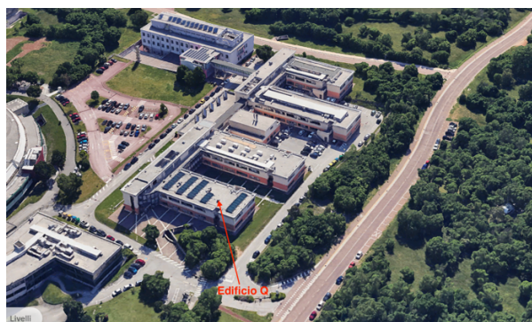
Edificio Q, sede dell'Istituto A. Volta
