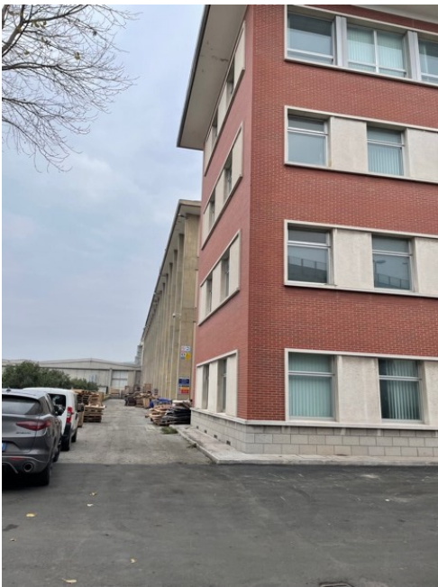
FOTO 3 FRONTE LATERALE SINISTRO
