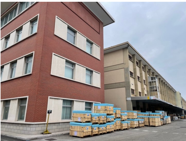
FOTO 4 FRONTE LATERALE DESTRO
