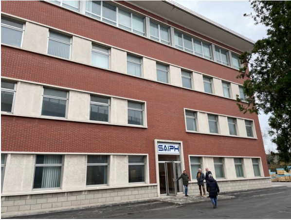
FOTO 1 FRONTE PRINCIPALE EDIFICIO
